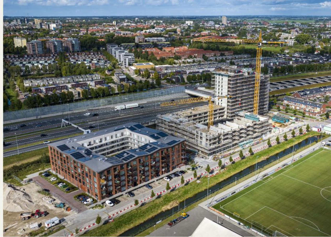
Appartementencomplexen The Hill en Three Towers aan de rand van de wijk Verde Vista in Zoeterwoude. ANP / Tobias Kleuver
